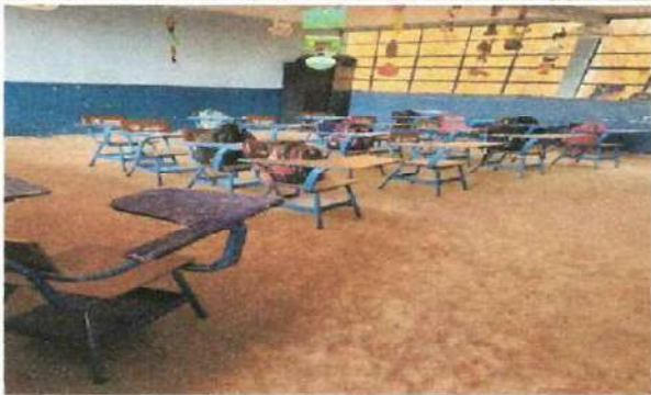
Foto1: Sustitución de torta de concreto en mal estado por piso ceramico e interior de aulas, para mayor durabilidad y mejoramiento de condiciones del ambiente escolar.
