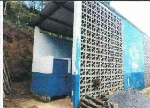
Foto 8: Circulación estructura metal y lamina troquelada de aluzinc calibre 26, area abierta en sanitario de varones.
