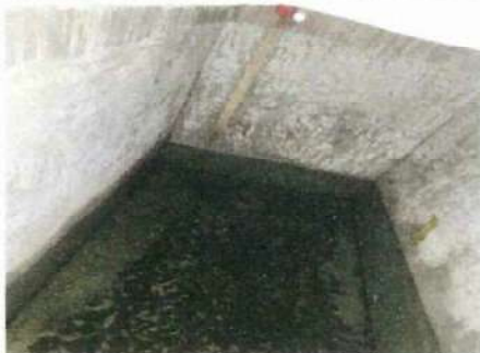
Foto 5: Reparación y mantenimiento tanque de agua, alisado y aplicación impermeabilizante.
