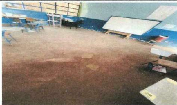
Foto3: Sustitución de torta de concreto en mal estado por piso ceramico e interior de aulas, para mayor durabilidad y mejoramiento de condiciones del ambiente escolar.
