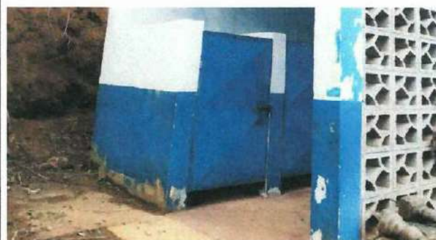
Foto 10: Fabricación e instalacion de puertas de metal 1.70 mts x 2.10 mts ingreso a sanitario de varones.
