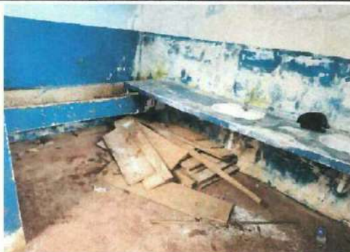
Foto 7: Sustitución chorro migitorio, grifos de 2 lavamanos, mangueras de abasto y contrallaves en sanitario de varones.
