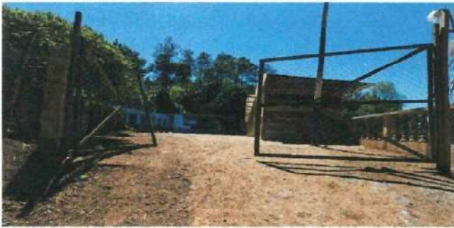
Foto 13: Fabricación e instalación porton de metal de 4.50 mts alto x 2.10 mts ancho, para ingreso al instituto y sustitución de 2 columnas de concreto.
