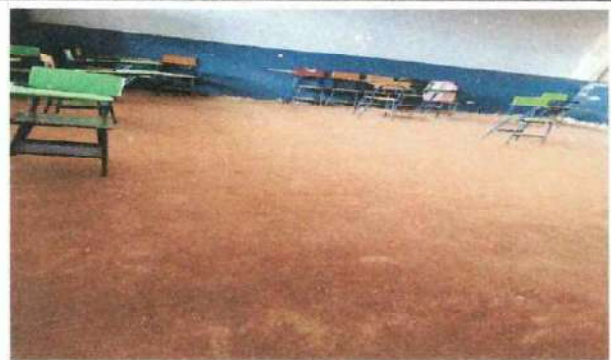
Foto2: Sustitución de torta de concreto en mal estado por piso ceramico e interior de aulas, para mayor durabilidad y mejoramiento de condiciones del ambiente escolar.
