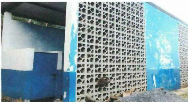
Foto 15: Aplicación pintura en exterior de paredes area de servicios sanitarios.
