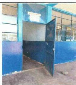
Foto 12: Reparación cambio de abatimiento 4 puertas, dirección, aula primero, aula segundo y aula tercero basico.
