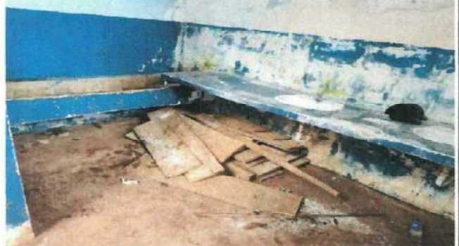
Foto 16: Aula 1, Aplicación de pintura en interior de paredes servicios sanitarios.
